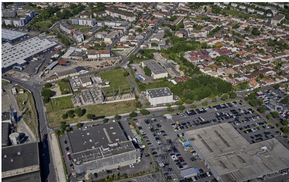
Vue aérienne (2021) © Philippe Caumes – Bordeaux Euratlantique
