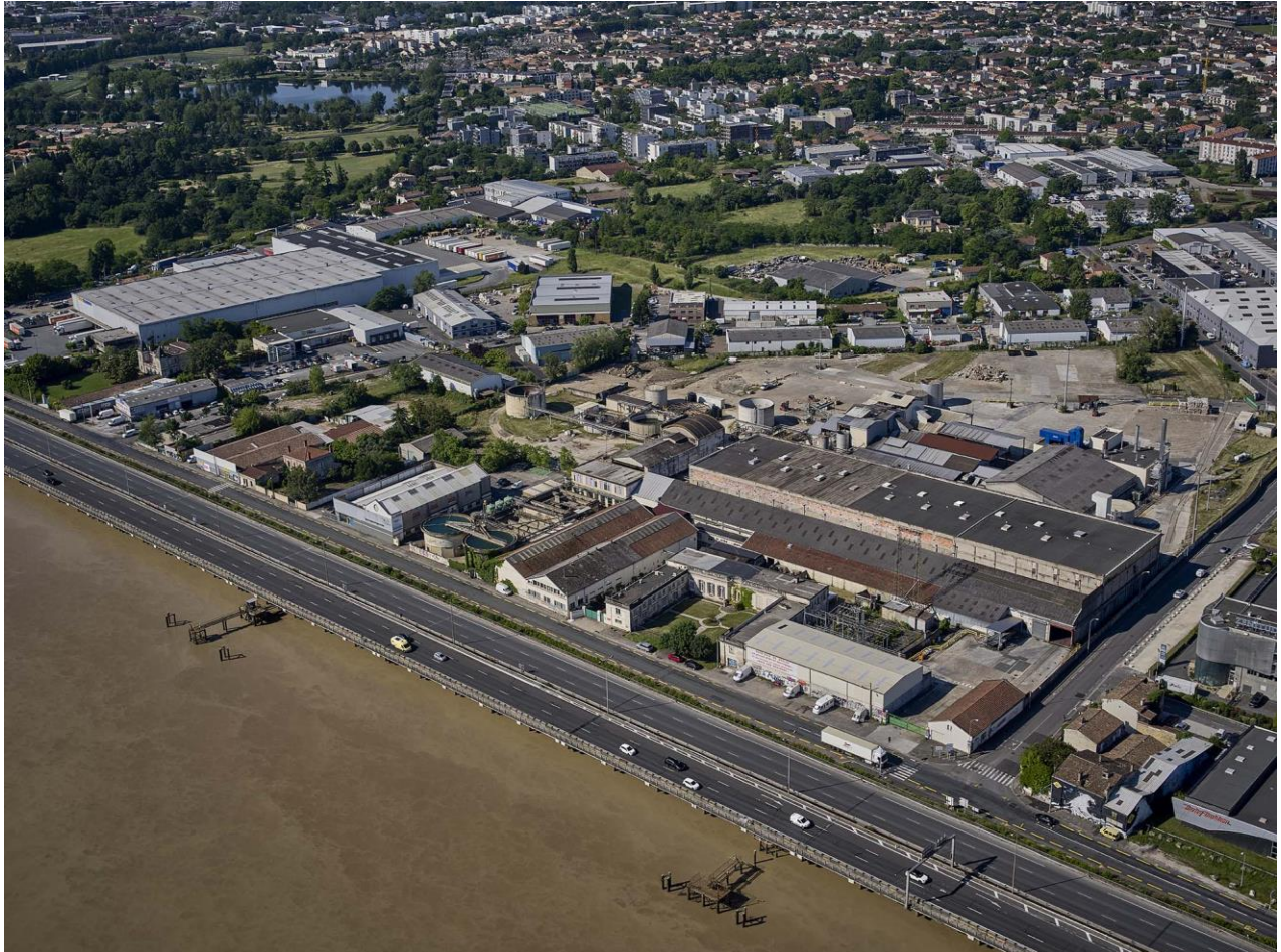
Vue aérienne du secteur IBA (2021) © Philippe Caumes – Bordeaux Euratlantique
