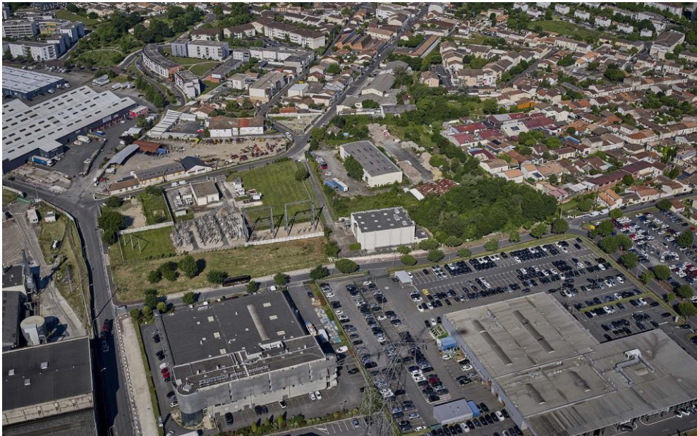
Vue aérienne (2021) © Philippe Caumes – Bordeaux Euratlantique
